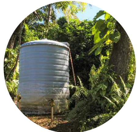
Cisterna para almacenamiento de agua
